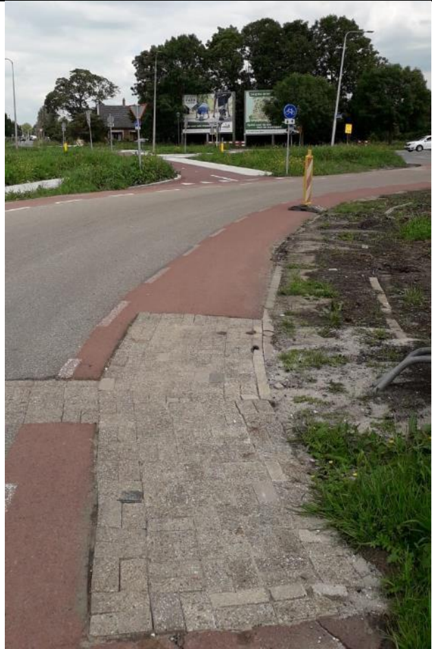
Rotonde Beijerincklaan- Zuidelijke Rondweg Zuidzijde
